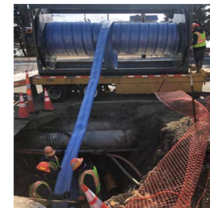
Eine frisch geteerte Straße zur Rohrsanierung wieder aufreißen? Das war in Kansas City dank Primus Line® nicht nötig.
