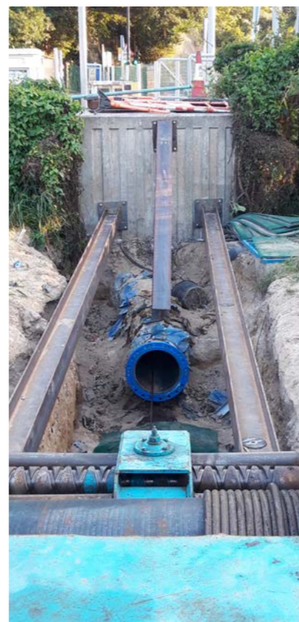
Vier bis sechs Leitungsabschnitte pro Monat saniert der Primus Line® Installationspartner derzeit in Hongkong.
