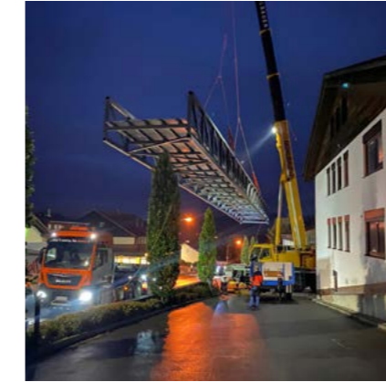
Als Sondertransport verlässt das Fachwerkbrückenteil das Firmengelände in Windischbergendorf.
