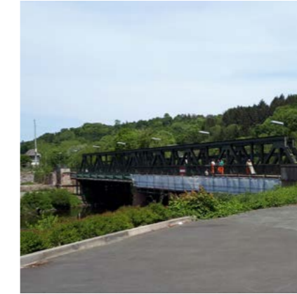
Direkt neben der bestehenden Eisenbahnbrücke quert die neue Stahlfachwerkbrücke in Weilburg die Lahn.
