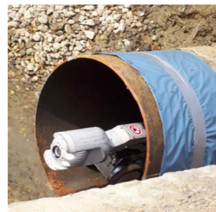
Am anderen Ende angekommen: Der Kamerawagen hat eine Reichweite von bis zu 1.300 Metern.
