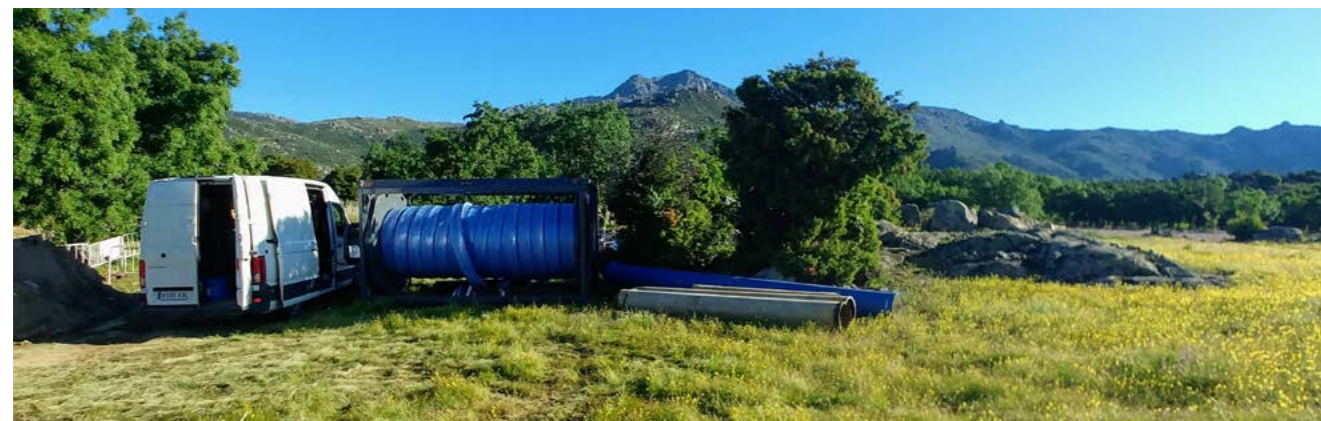
Im Guadarrama-Nationalpark in der Nähe von Madrid sorgte die grabenlose Sanierung mit Primus Line® für eine erhebliche CO 2 -Einsparung bei der Installation.
